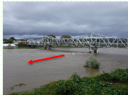
10月23日増水時 大石田大橋
