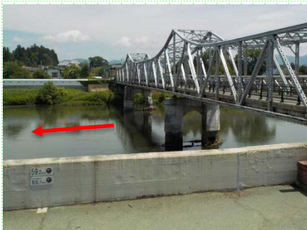
平常時 大石田大橋
