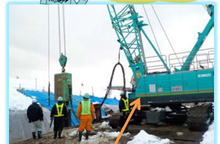
この特殊車両は、鋼矢板を持ち上げて地上に打ち込むときに使うクローラークレーンという機械なんだって！写真に収まらないくらい大きかったよ！！
