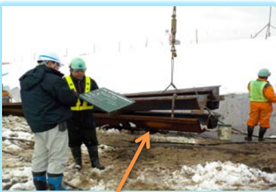
10mもある鋼矢板を地中に 打ち込むんだよ！
