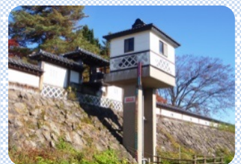
大石田第3排水樋管
