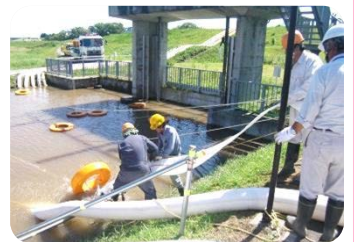
▲9月12日、渋井川(宮城)での排水作業の様子
