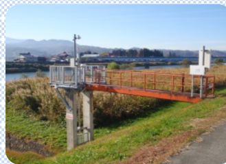
今宿第1排水樋管
