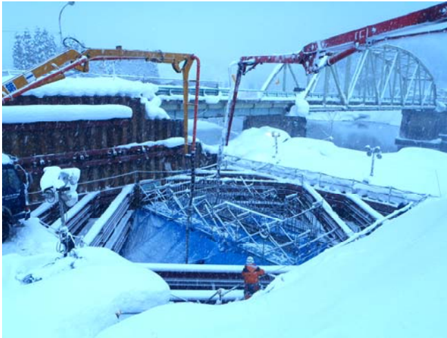
▲ 大雪の中での「コンクリート打設」作業状況
