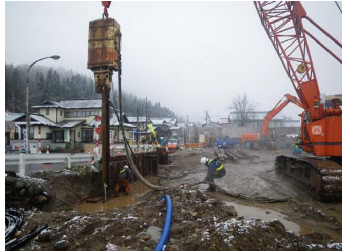
▲ 固い地盤への「矢板打ち込み」作業状況
