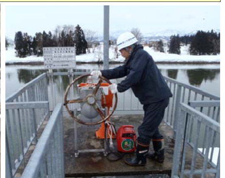
▲ 排水樋管操作状況
