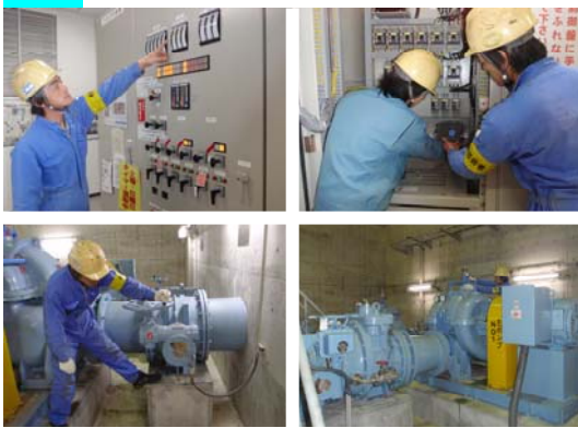
大石田消流雪揚水機場の点検の様子
