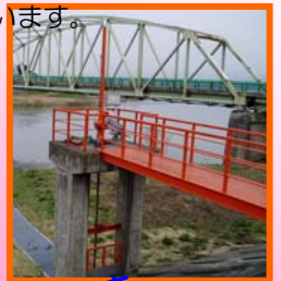
毎月、樋管点検を行っています。
