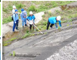
←舗装の損傷箇所を確認。へこみ部分を測定し、補修が必要か判断します。
