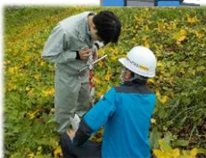
←貫入棒を使い、地盤の緩みがないか、のり面の状態を確認しています。
