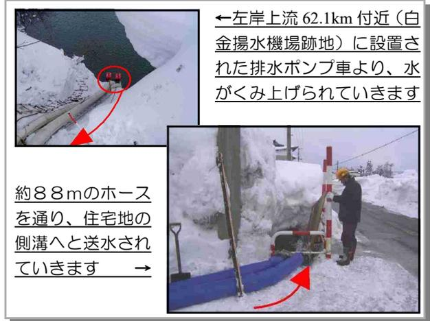
←左岸上流 62.1km 付近（白金揚水機場跡地）に設置された排水ポンプ車より、水がくみ上げられています
