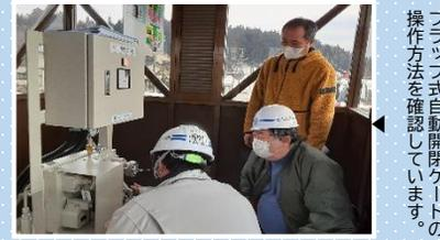
フラップ式自動開閉ゲートの操作方法を確認しています。
