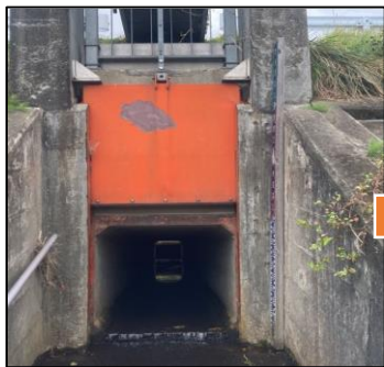
【今宿排水樋管】着工前
