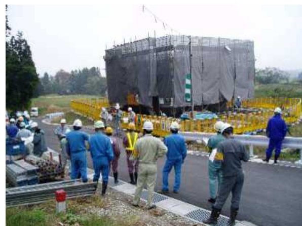
操作室新築工事の現場パトロールの様子
