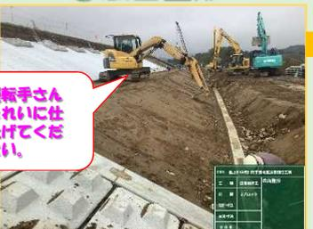
重機で入念に堤防の形を作り（整形）、整形された部分へ遮水シート（堤防に水が浸透するのを遮るシート）を、設置します。
