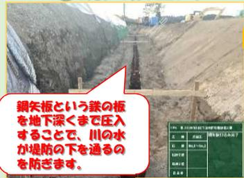
鋼矢板という鉄の板を地下深くまで圧入することで、川の水が堤防の下を通過のを防ぎます。
