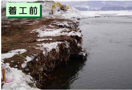
昨年7月の洪水による 河岸洗掘状況
