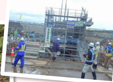
▲最上川中流蔵岡地区 治水対策工事 点検場所: [戸沢村蔵岡地区]
