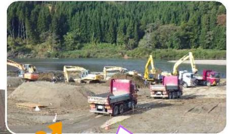
掘削された土砂は改良され、盛り土材として有効活用されます。
