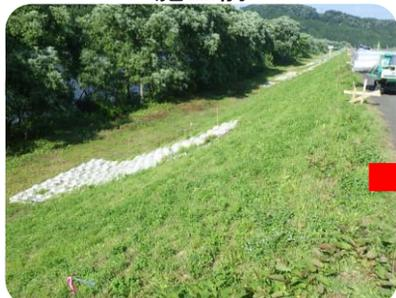
昨年度の出水で堤防の崩れた箇所をブロックにより応急復旧
