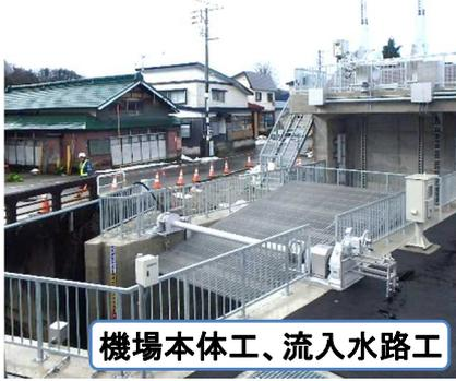
【工事概要】蔵岡地区での樋管改築工事に伴い設置した迂回路を撤去し、水路の整備を行いました。
