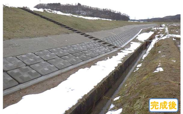
【工事概要】大雨が降り川が増水し越水<sup>えっすい</sup>してしまったとき、被害を最小限にとどめる為に、堤防裏法尻にブロックを敷き詰めて強化を図りました。
