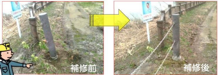
雪の重さで立入防止柵が傾いていたので、土台をしっかり固定し補修しました。
