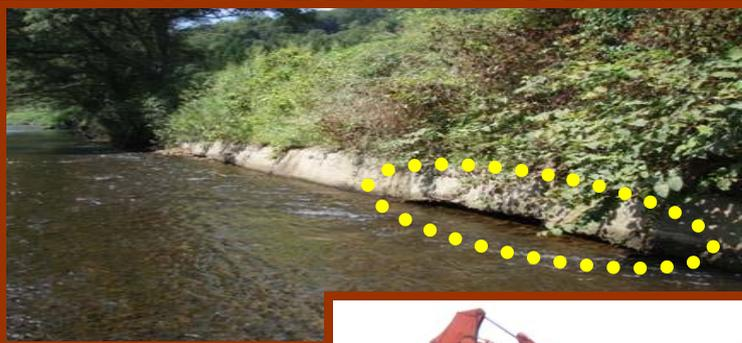
▲ 低水護岸法留め洗掘箇所の状況
