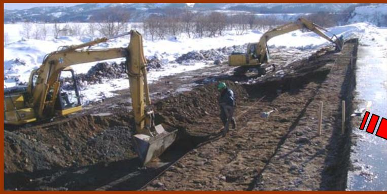
▲ 質の低下した土砂を剥ぎ取り、土砂の定着を良くするため階段状に整形し、良質な土砂の安定を図ります。
