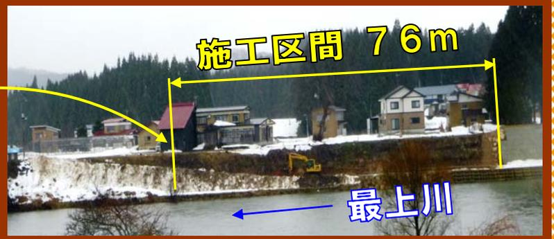
堤防は土を盛りたてるのが原則ですが、住宅が接近しているなどで堤防の用地取得が困難な場合、コンクリートや鋼矢板（鉄を板状にしたもの）などで築造した堤防をとくしゅてい特殊堤といいます。
