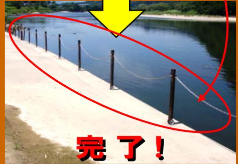
洪水や積雪などにより損傷した転落防止柵を補修することで、河川への転落等を防ぎ、安全を確保します。
