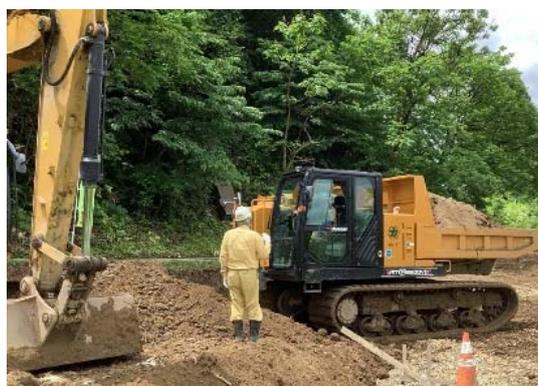
図-4-1、2 トランシーバーによる誘導状況
