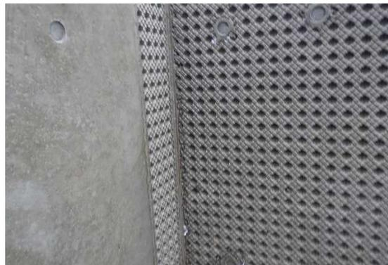
写真-6 脱型後打継面
