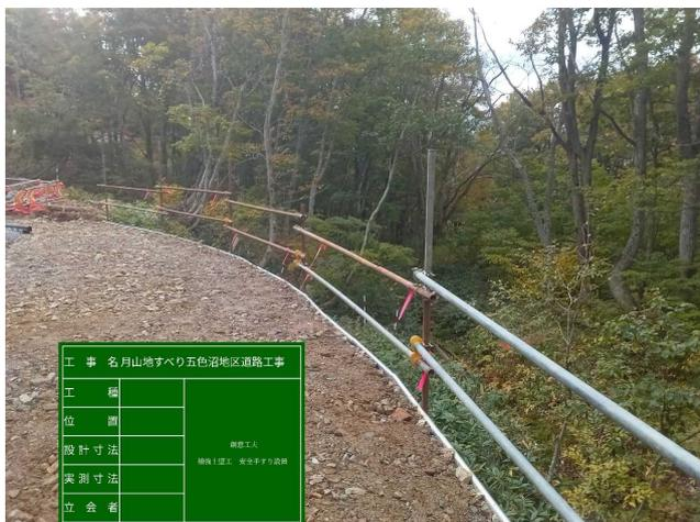
写真-1 転落防止柵設置完了
