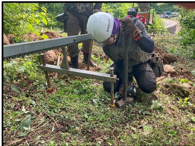
写真 4 支柱挿入状況
