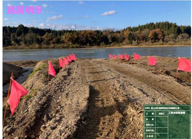
現在は場内運搬で坂路の拡幅作業を行っています。過積載が原因でダンプの制動距離が長くなる恐れもある為、積み込み回数を定め、適時ポータブル重量計で車両総重量を測定し、車検証と対峙し過積載確認を実施しています。
