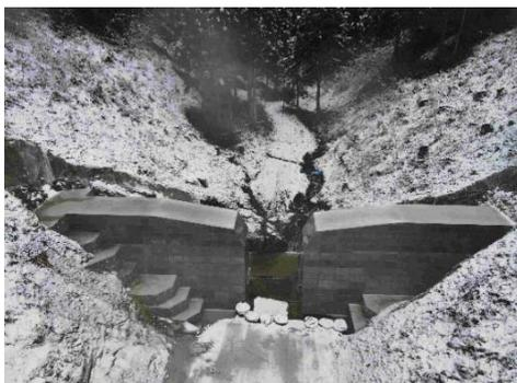
写真-16 コンクリート堰堤本体工 袖部完成
