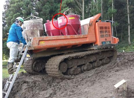
運搬車両荷台の昇降設備
