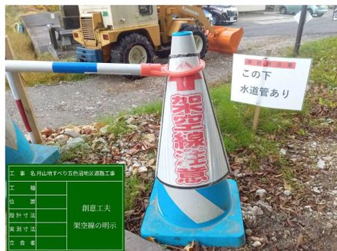
写真-9 架空線のカラーコーンによる明示
