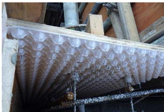
写真-5 打継処理シート型枠貼付
