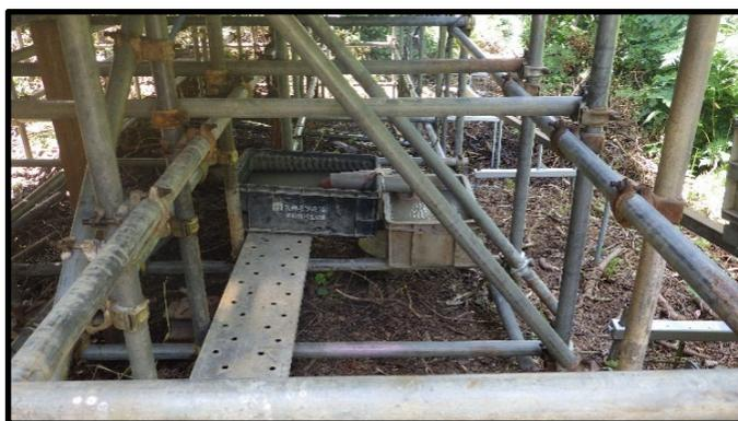
写真 7 泥水を沈殿させるためのトレー
