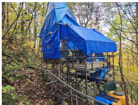
写真-1 調査ボーリング全景
