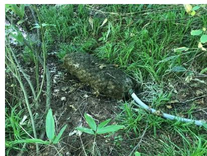
写真-9 濁水処理（ろ過材設置）
