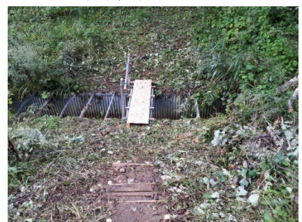
写真 2.3.5 仮設栈橋使用状況
