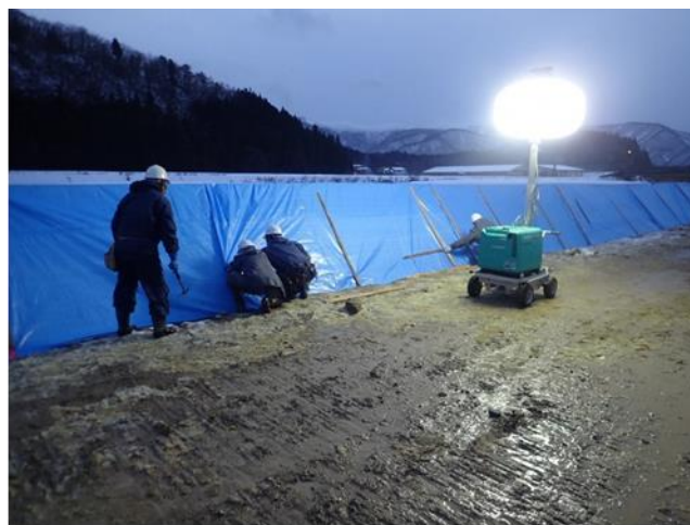
天端保護工施工時
