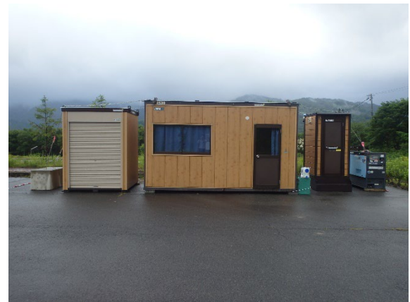
写真 2.2.4 現場事務所設置状況
