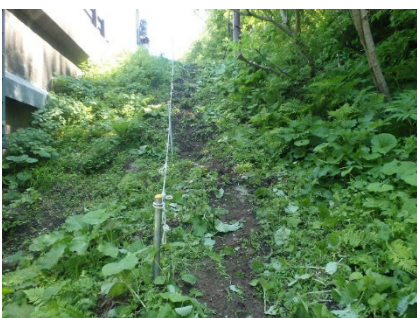
写真 2.3.3 介助ロープ設置状況
