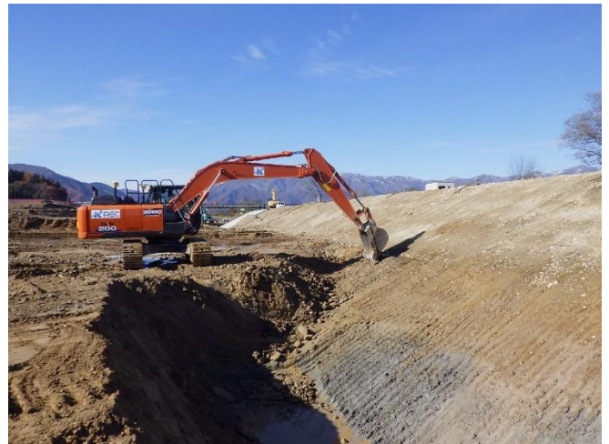
【ICT 搭載バックホウによる施工状況】
