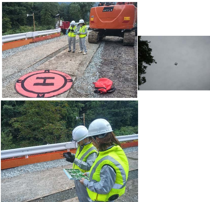
写真-10 女性技術者によるドローン測量
