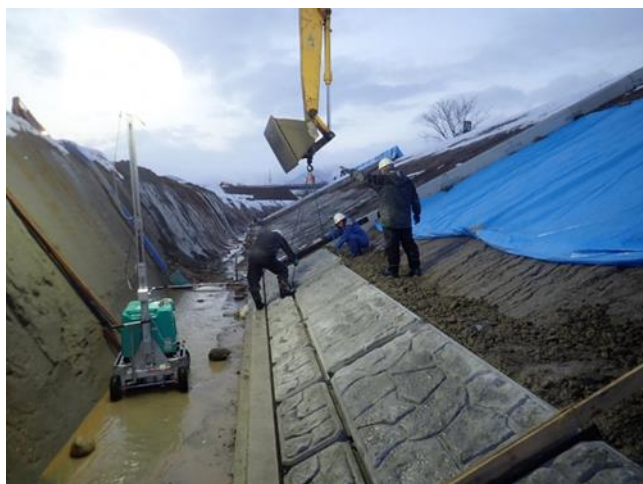
平ブロック張施工時
