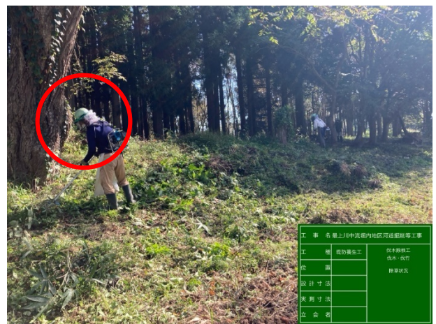
写真8 人力による除草状況
