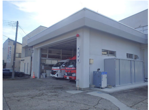
写真 2.2.2 西川町消防署
