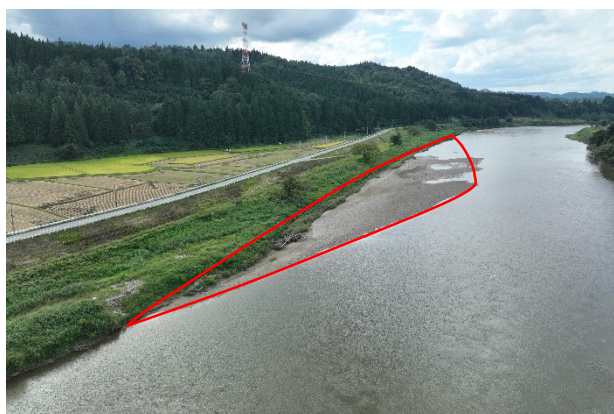
写真1 河道掘削箇所
