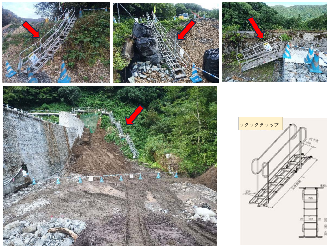
写真-2 設置状況
