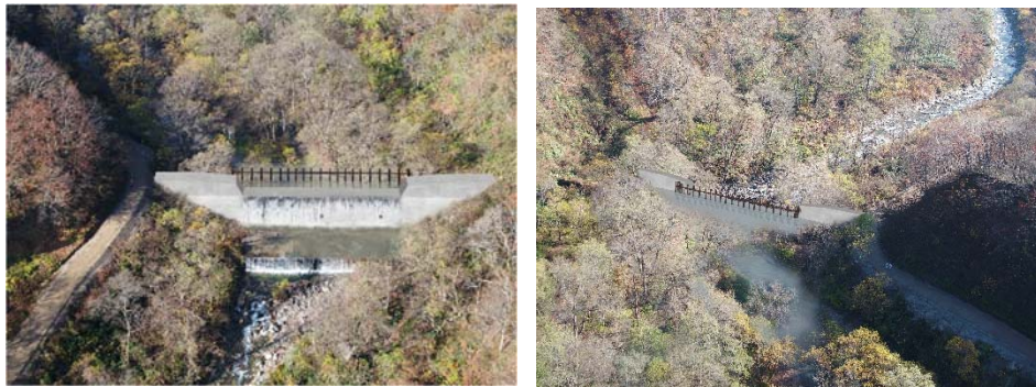
図-1 流木止め設置完了イメージ
