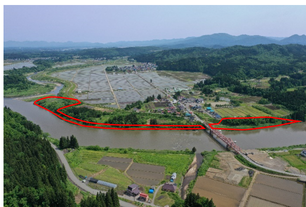
写真2 伐木・伐竹箇所
