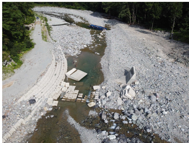
着工前 橋台工(上流より下流を望む)
