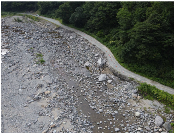
着工前 応急処理工(下流より上流を望む)
