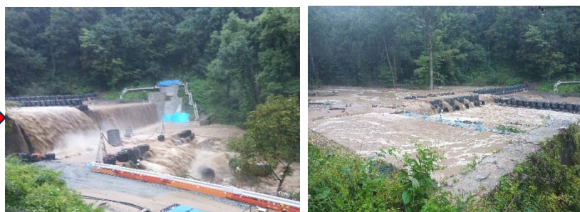
写真-9 被災状況
