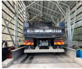
写真-6 トラックスケール
