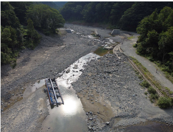
着工前 橋台工(下流より上流を望む)
