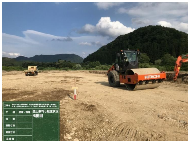
【ICT搭載振動ローラーによる施工状況】
