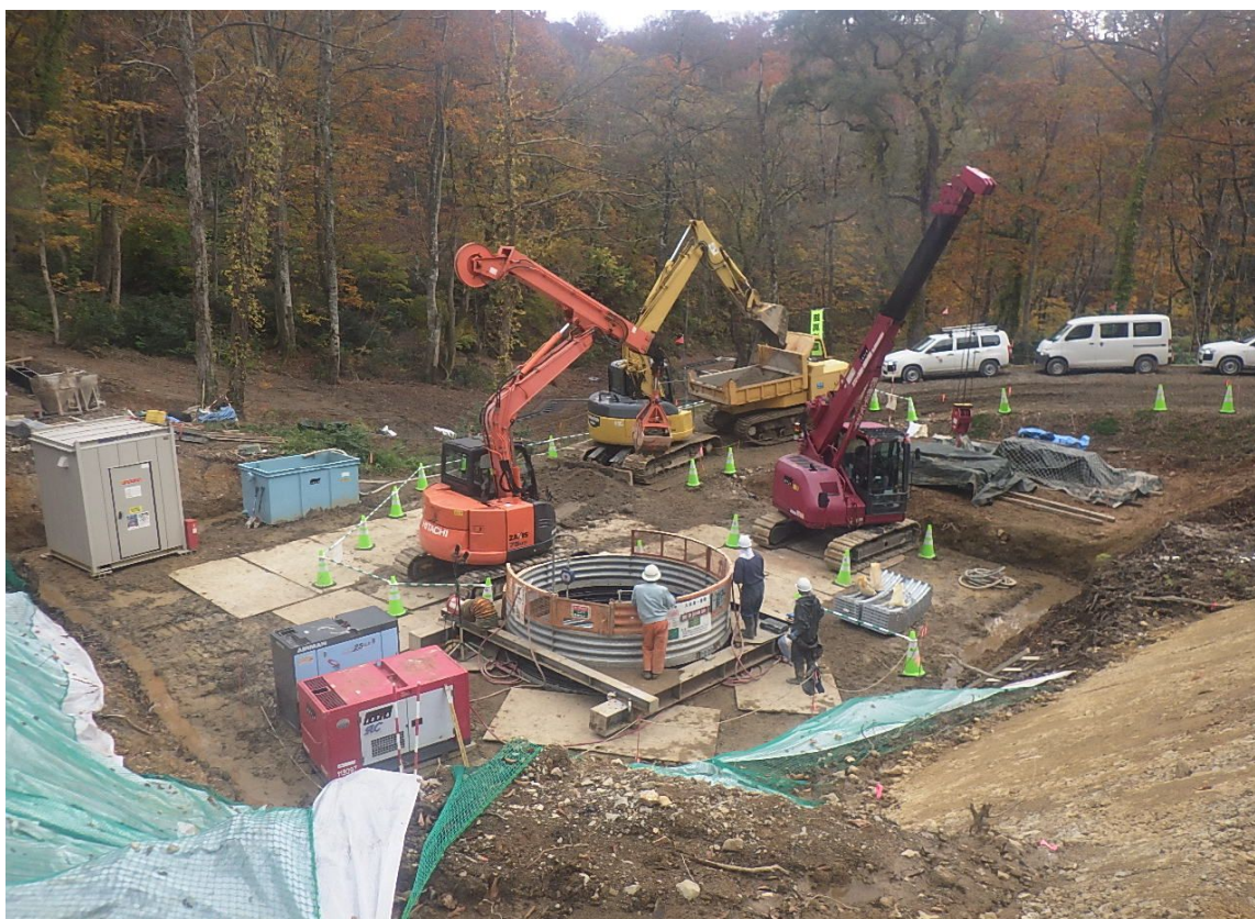
写真-1 集水井掘削状況
