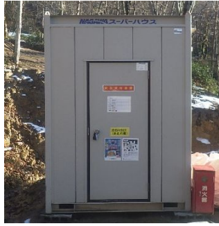
緊急資材倉庫
