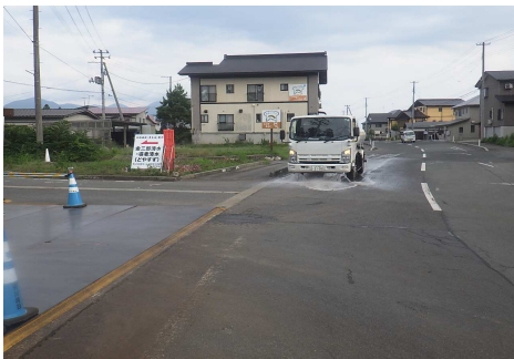
道路清掃状況
