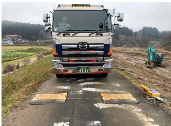
【 トラックスケール設置状況 】
