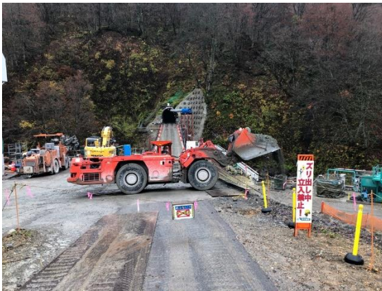
ズリ出し (LHD 使用) 時の立入禁止処置
