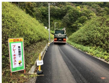
ブレーキテスト（制動距離確認）
