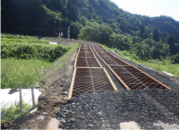
滑り止めメッシュ敷鉄板設置状況
