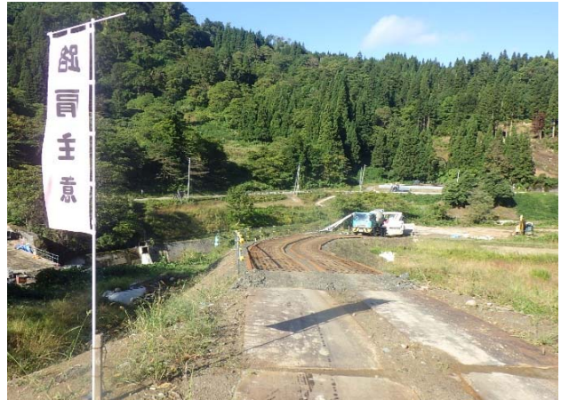
コンクリート打設状況
