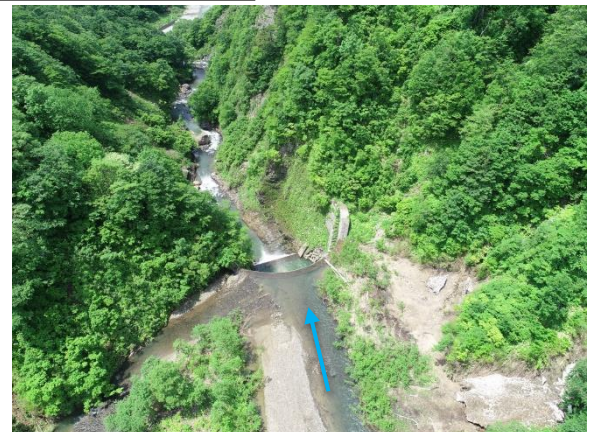
赤沢第1砂防堰堤の上流側からの状況
