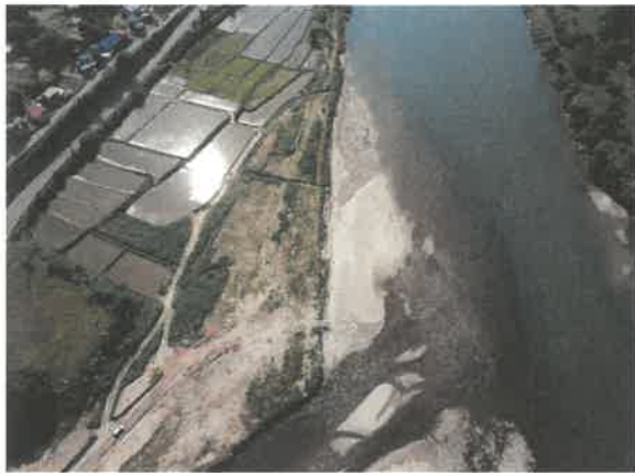
【着工前】 (古口地内)
