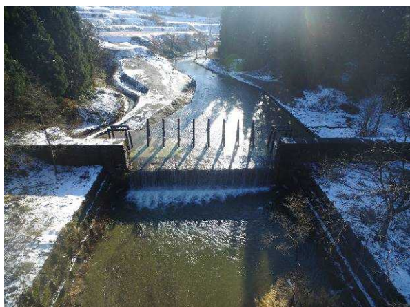
(滝の沢第2砂防堰堤)
