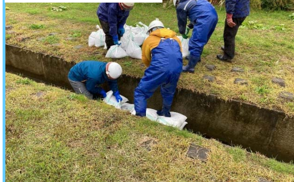
【土のうの設置】
