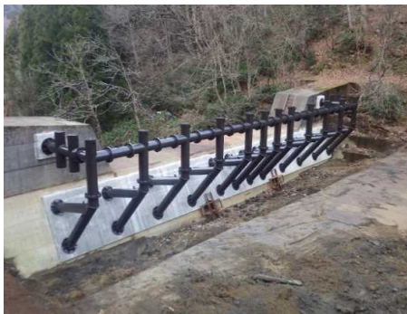
【花戸川地区 鋼製流木止め】
