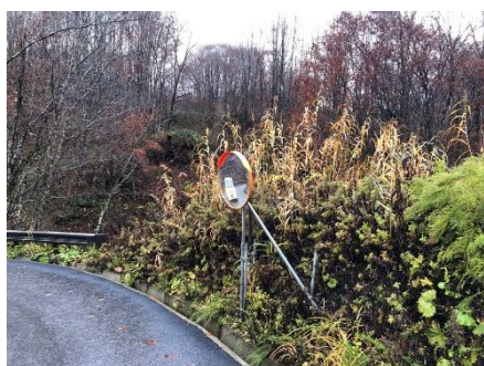
急曲線部カーブミラー設置
