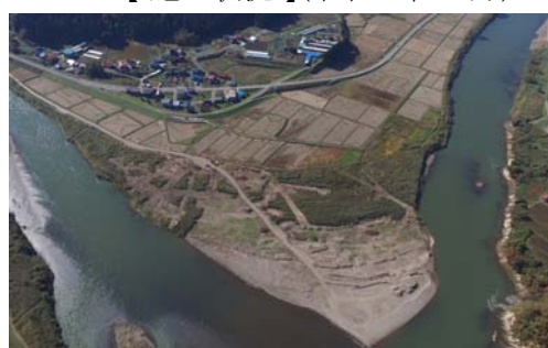
【 施工状況 】(令和 3年 11月)
