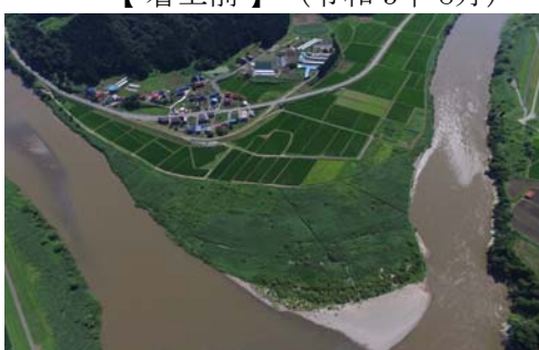
【 着工前 】 (令和 3年 8月)
