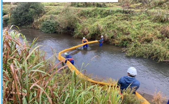
【オイルフェンスの設置】
