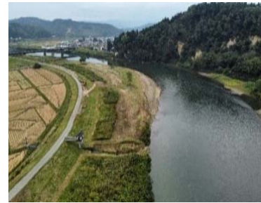
除草完了（白須賀工区）
