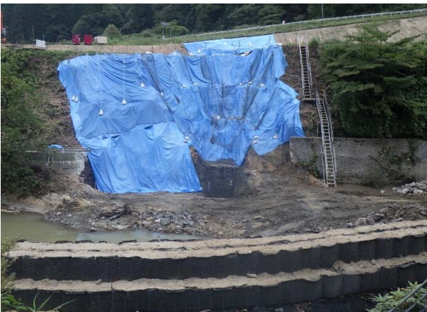
掘削完了時法面シート及びネット養生状況
