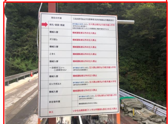
門型ゲート、作業行程看板設置
