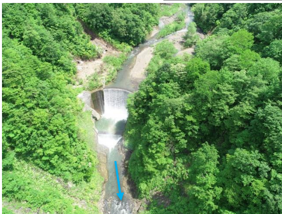
赤沢第1砂防堰堤の下流側からの状況
