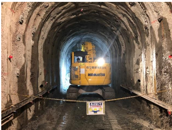
切羽への立入禁止措置（機械掘削時）
