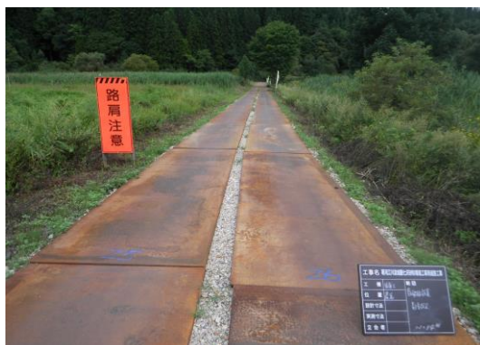
農道敷鉄板設置
