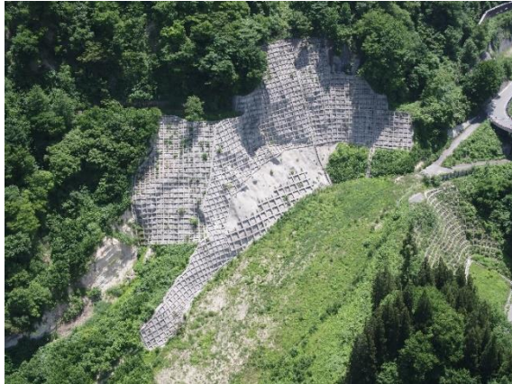
写④ 肘折山腹工
