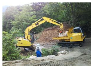
大型土のう積み込み状況
