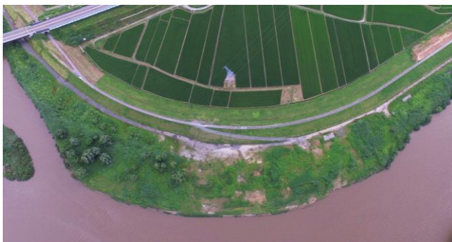
【着工前】（令和2年8月）
