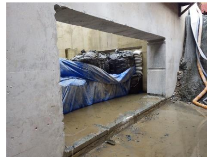
開口設置完了
