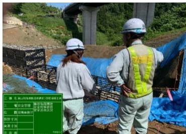
(写真-4) 安全巡視
