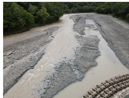
土砂仮締切決壊
