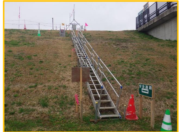
避難・作業通路の確保で簡易階段設置
