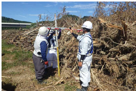
【高さ確認状況】
