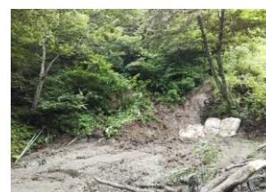
大型土のう設置状況
