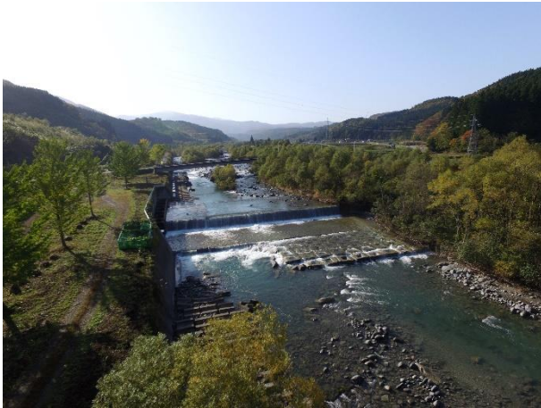
科沢地区着工前
