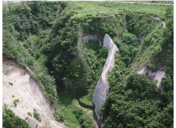
写⑤ 大曲沢山腹工
