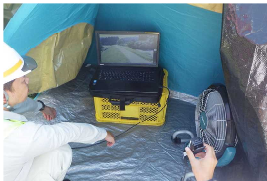
【簡易テント内状況】
