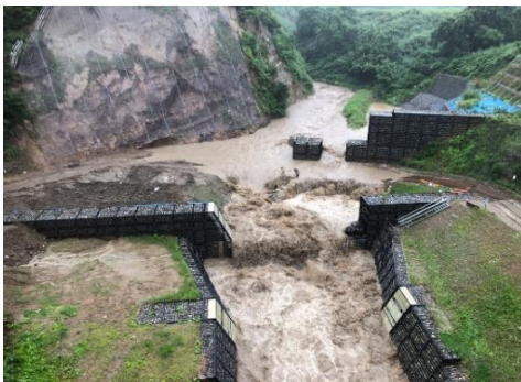
集中豪雨（7月28日）の現場状況
