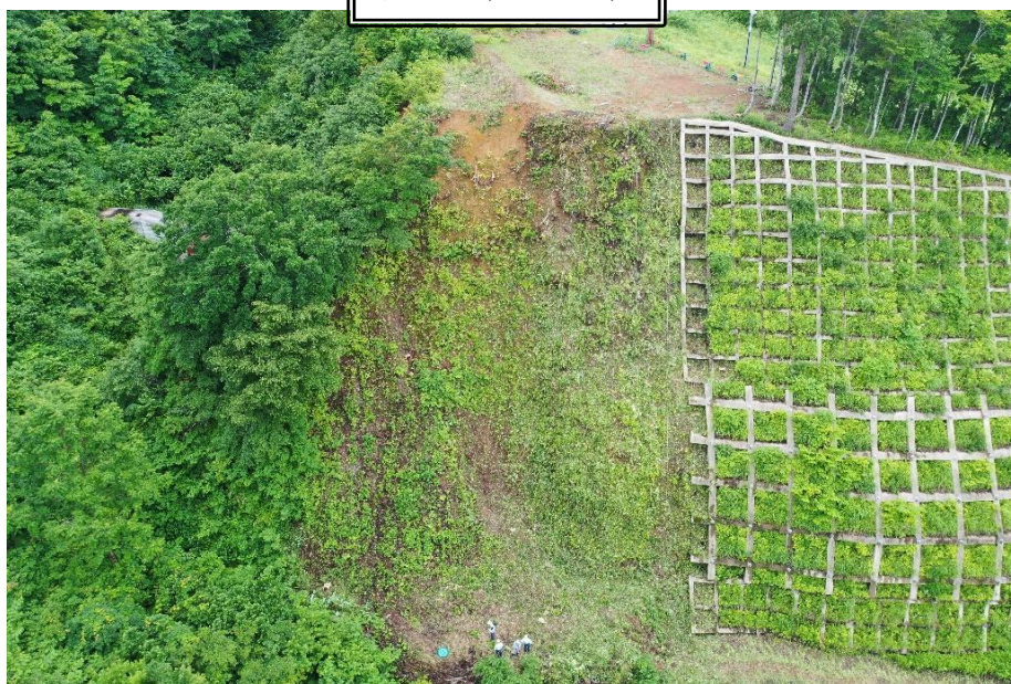
着工前（上空より）
