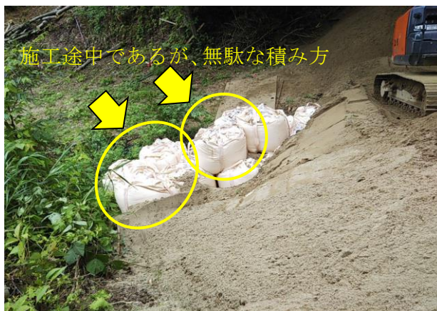
大型土のう設置状況
