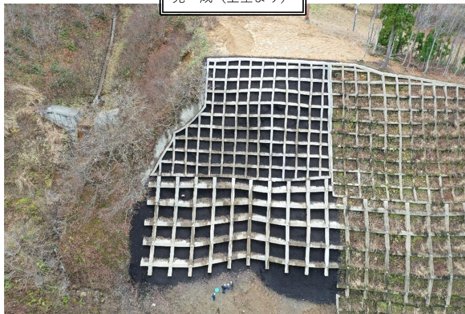
完 成（上空より）
