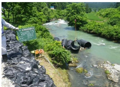
流出物撤去状況
