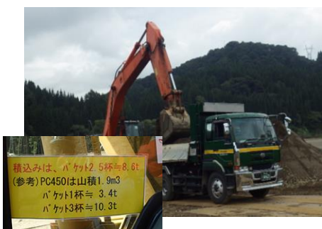
【土砂積込み状況】
