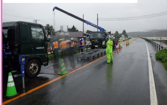
【戸沢村蔵岡地区で夜間作業】
