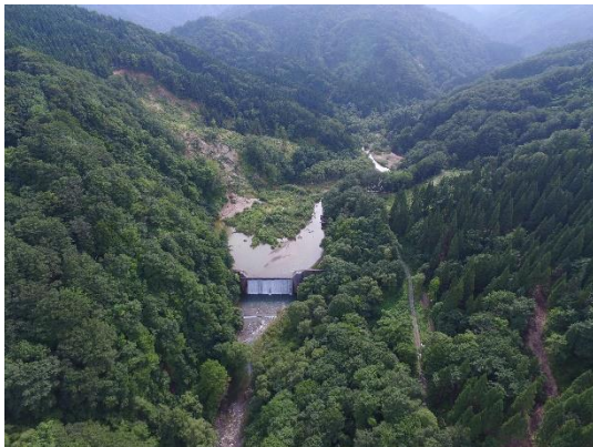
写⑥ 角川砂防堰堤
