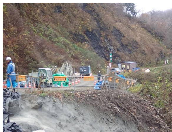
写真-6 転落防止柵設置状況
