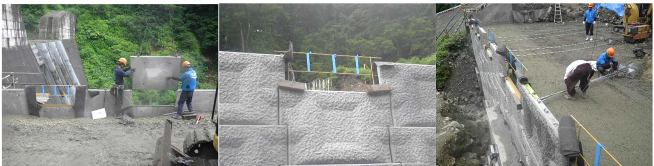
写真 13. オリジナル転落防止柵 設置状況
