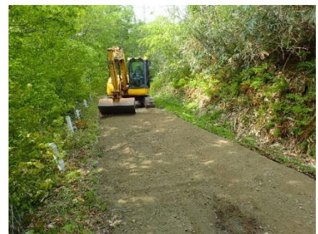
写真-2 工事用道路（市道）
