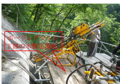
木製足場使用
