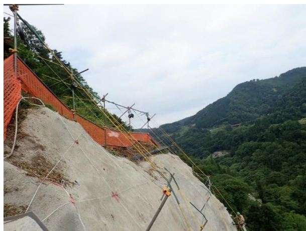
写真-4 落石防止ネット設置状況
