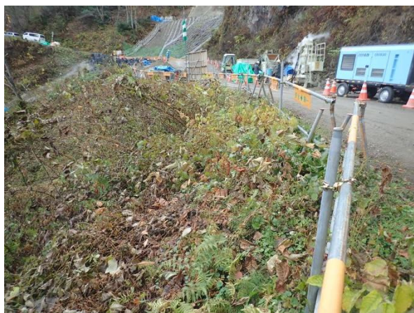
写真-6 転落防止柵設置状況
