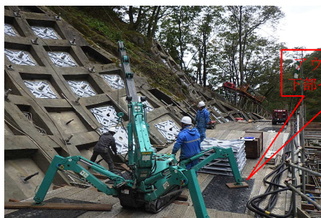
カニクレーン使用状況
