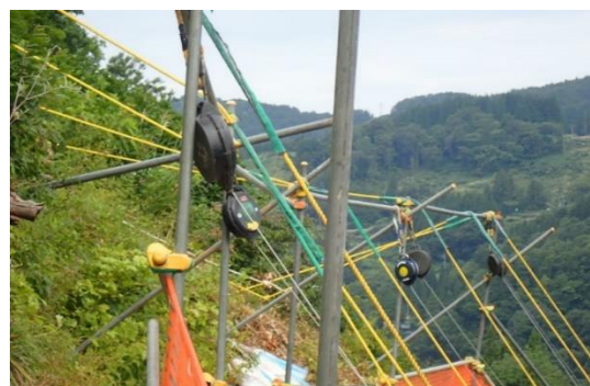
写真-7 セーフティーブロック設置状況
