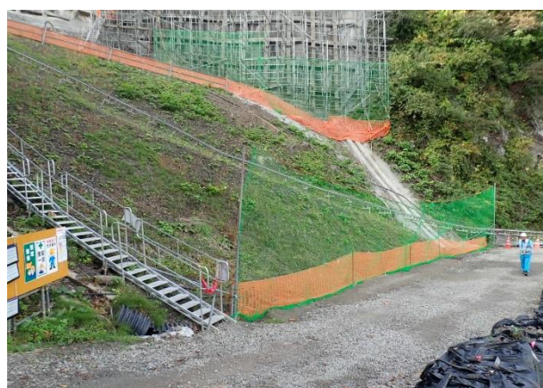
写真-5 資材落下防止ネット設置状況
