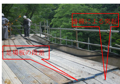
段差有り・番線固定
