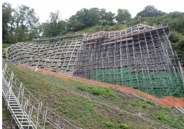
写真-5 資材落下防止ネット設置状況
