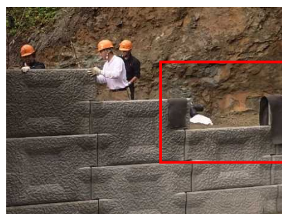
写真11. 多数アンカー式工法
