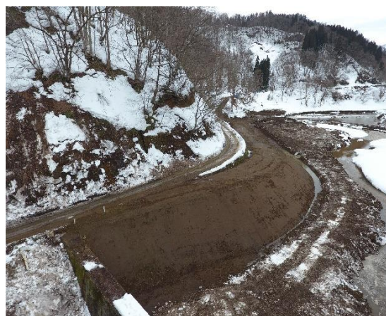
今回の工事用道路完成部分 施工延長L=114.3m
