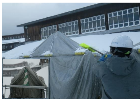
カラーコーン使用した 場合の除雪状況
