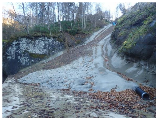
写真-9 盛土断面復旧と明暗渠工施工 着手前・完了全景
