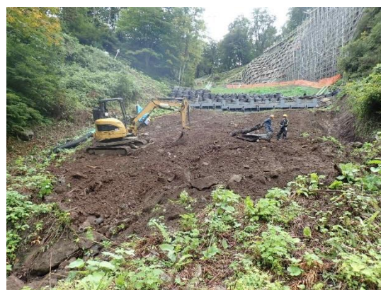
写真-8 セーフティークライマーによる盛土断面復旧状況
