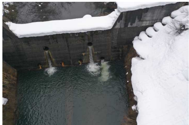
図 3.2 大石川 堤体前面
