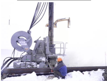
7年前の施工管理状況
