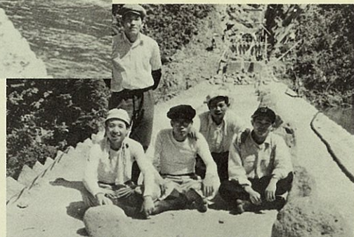
昭和33年頃 本沢ダム工事中
