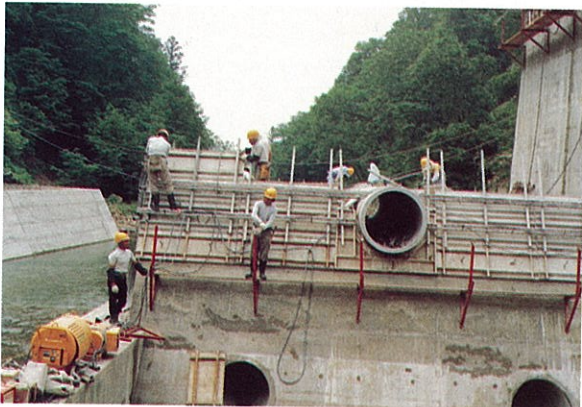
小又川ダム工事中
