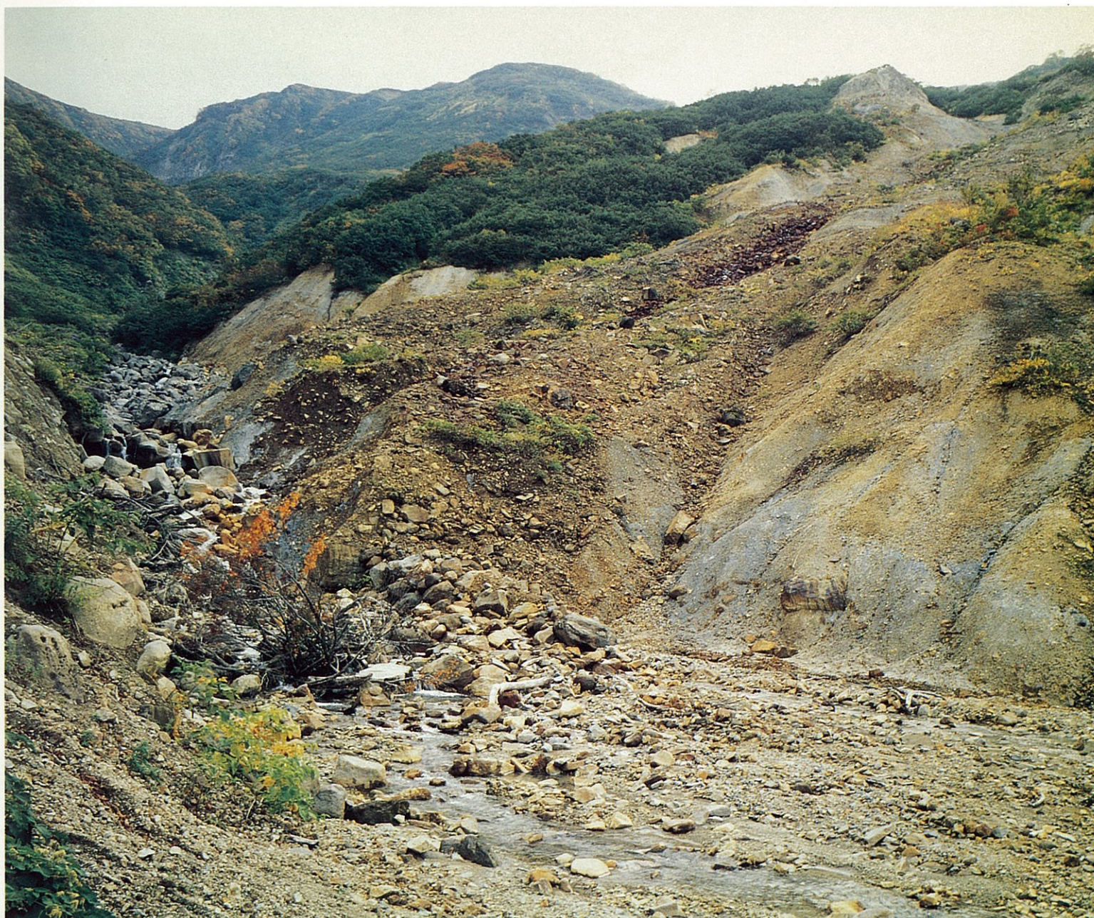
濁沢川上流部の崩壊地
