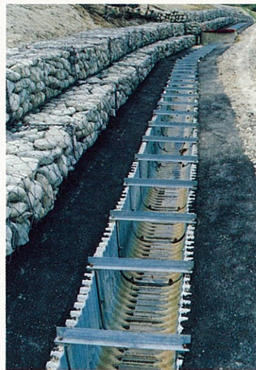
コルゲート排水路
