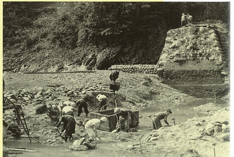
月岡ダム工事中
