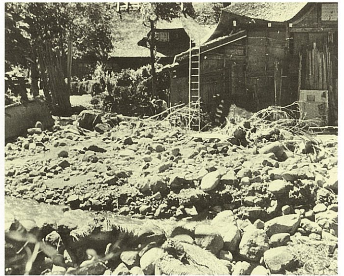
昭和34. 7. 22豪雨 朝日村大字岩本地内の土砂災害状況
