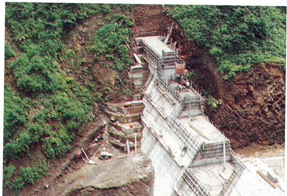
小又川ダム工事中
