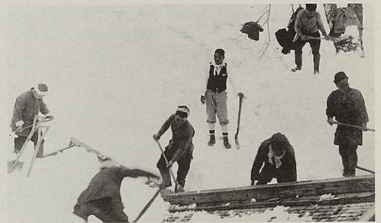
昭和13年 5月2日 立谷沢砂防工場の除雪作業
