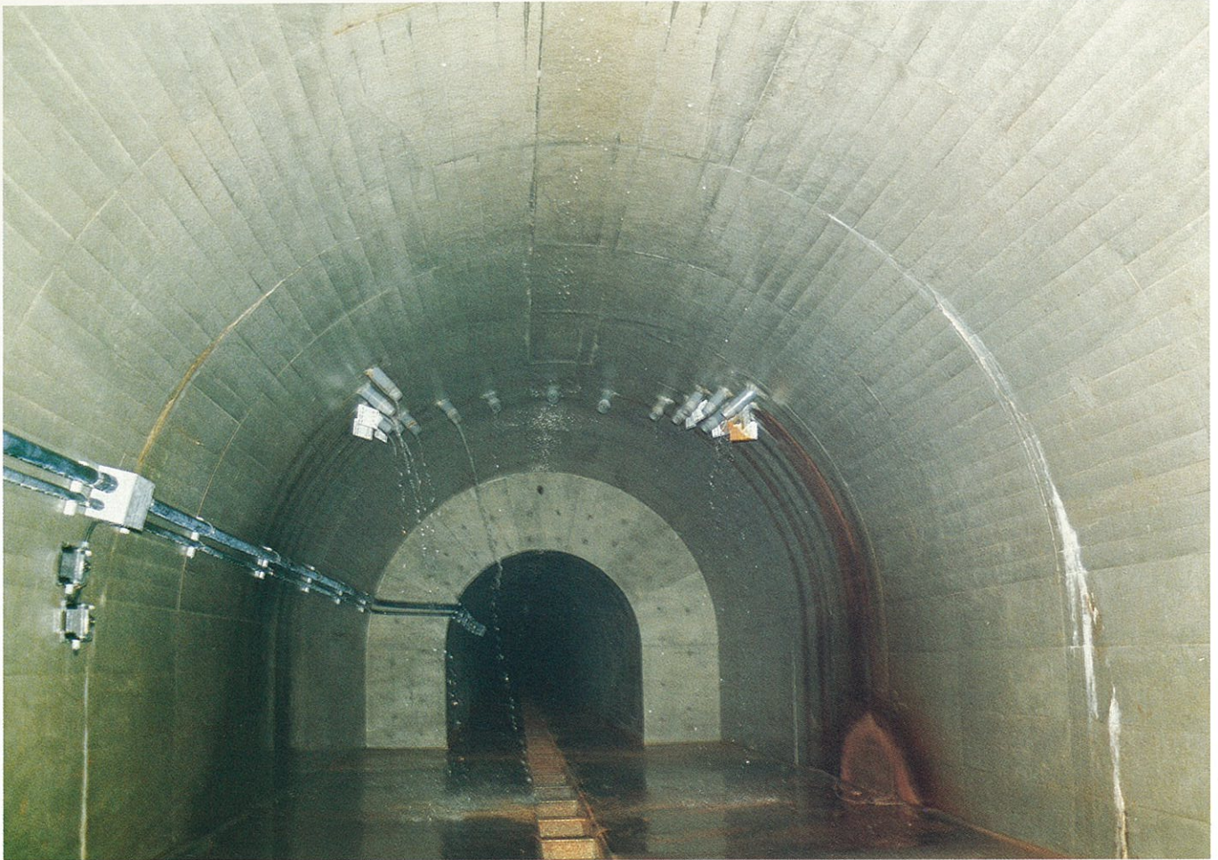
豊牧排水トンネル内部
