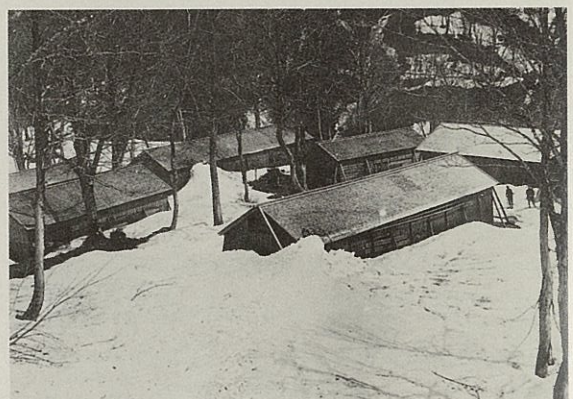
昭和14年 本沢地内 濁沢ダム工事のための労務者宿舎
