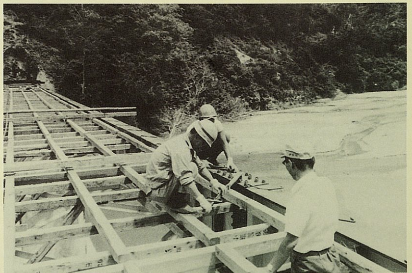
昭和48年頃 本沢ダム工事中
