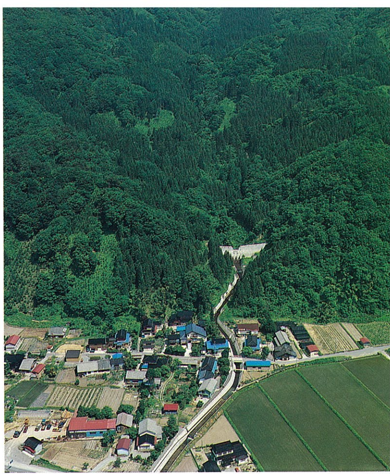
科沢地区を土石流から守る砂防ダム
