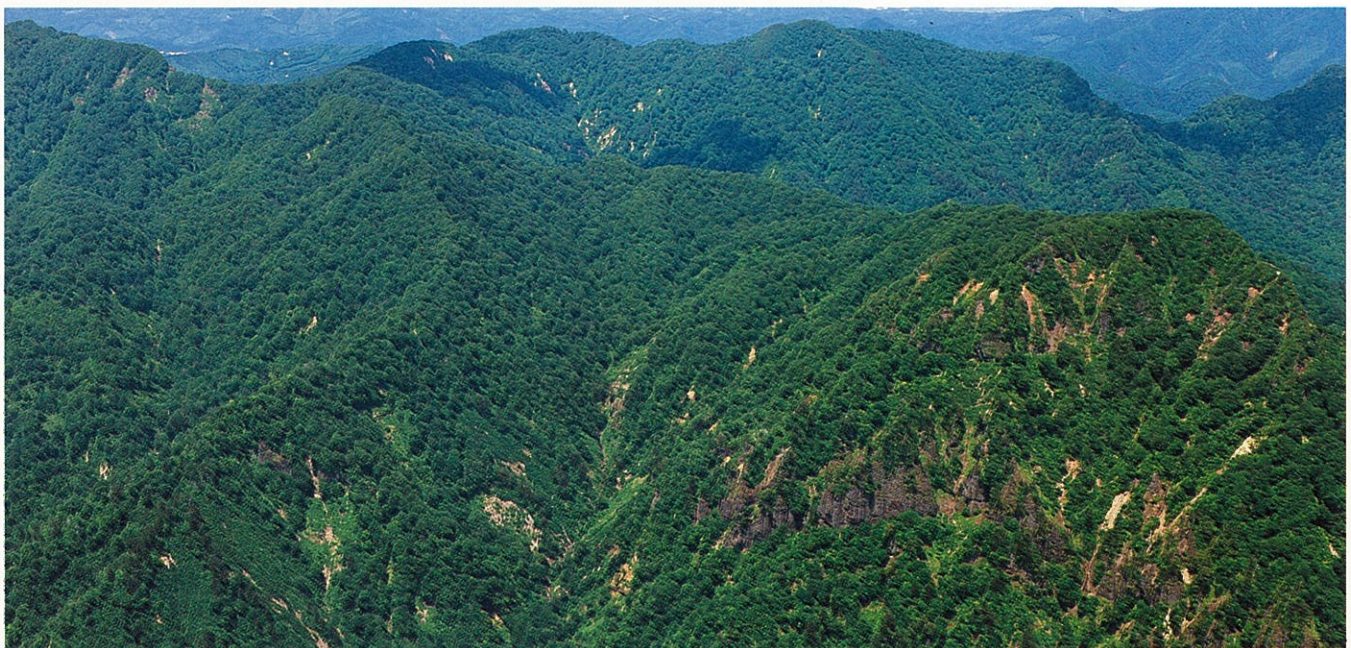
小又川上流崩壊地
