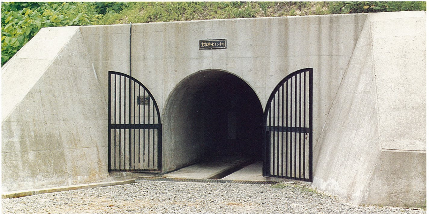
豊牧排水トンネル
