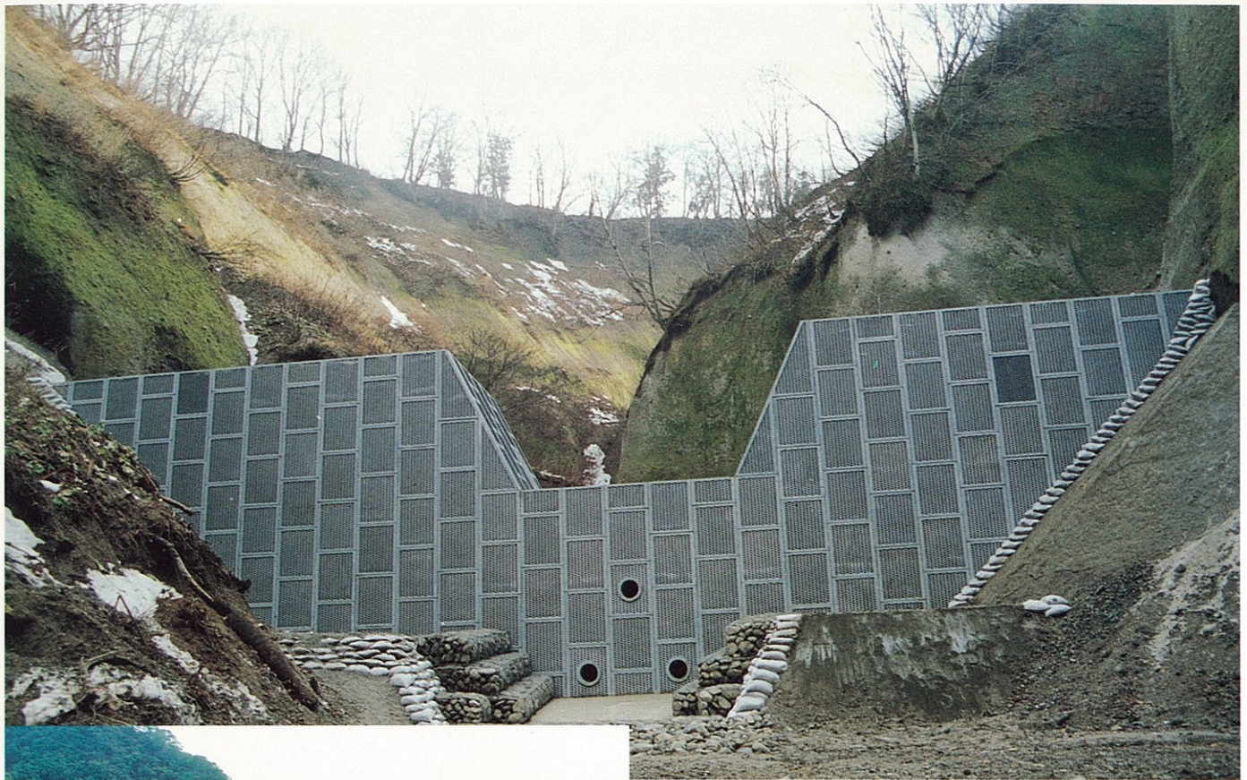
大曲沢第3ダム 昭和62年度完成予定
