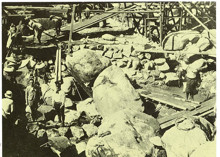
濁沢第2ダム工事中
