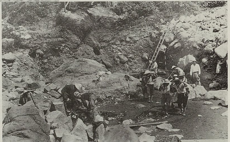
昭和13年 8月8日 立谷沢川支流濁沢第1号堰堤掘削
