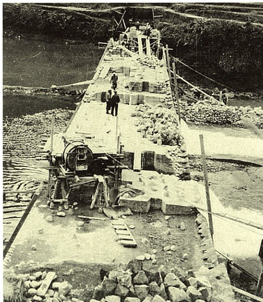
肘折ダム工事中
