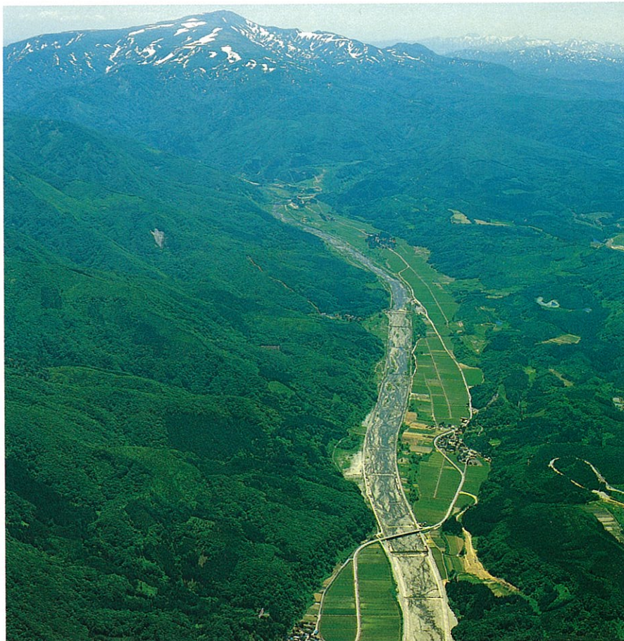
立谷沢川流路工
