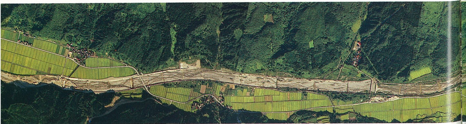
立谷沢川 流路工着工後 （昭和62年8月）
