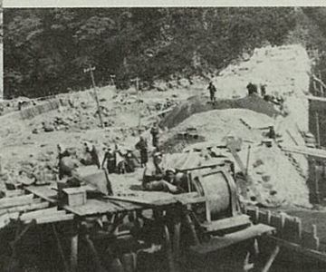
昭和25年 六淵本堰堤
