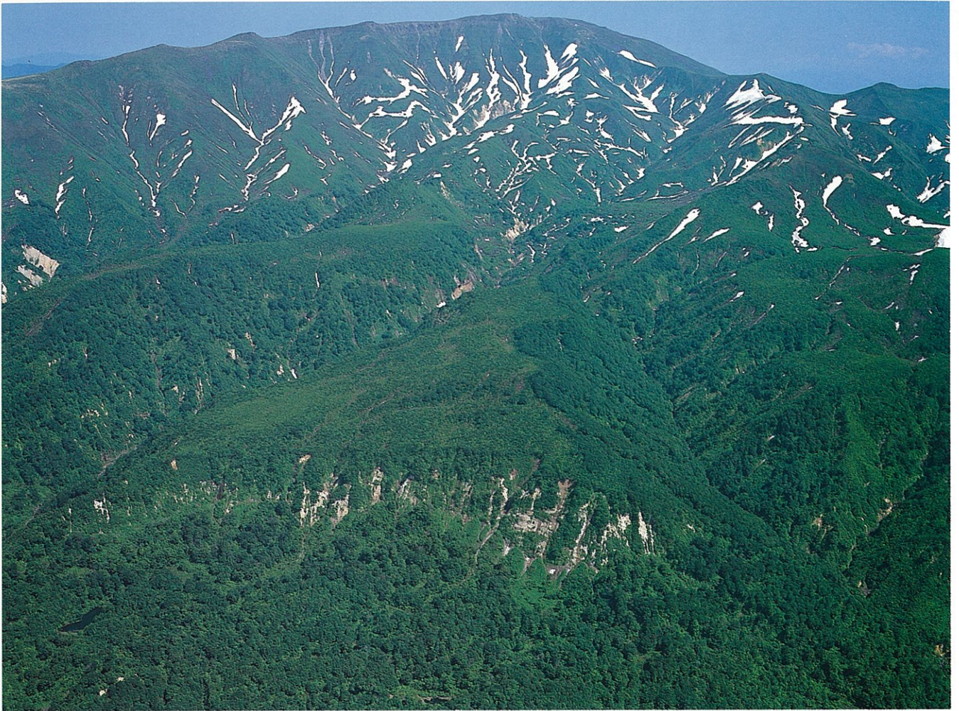
田麦川上流の崩壊地
