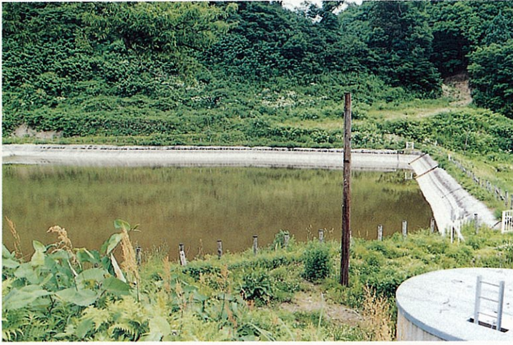
五郎八沼の浸透防止工
