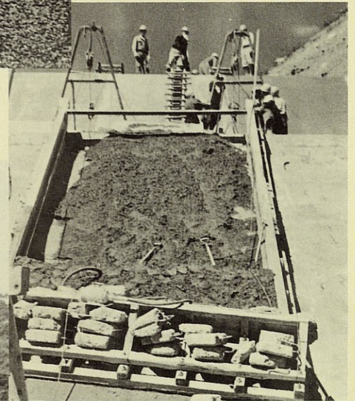
昭和41年9月 潜岩ダム右岸保護工
