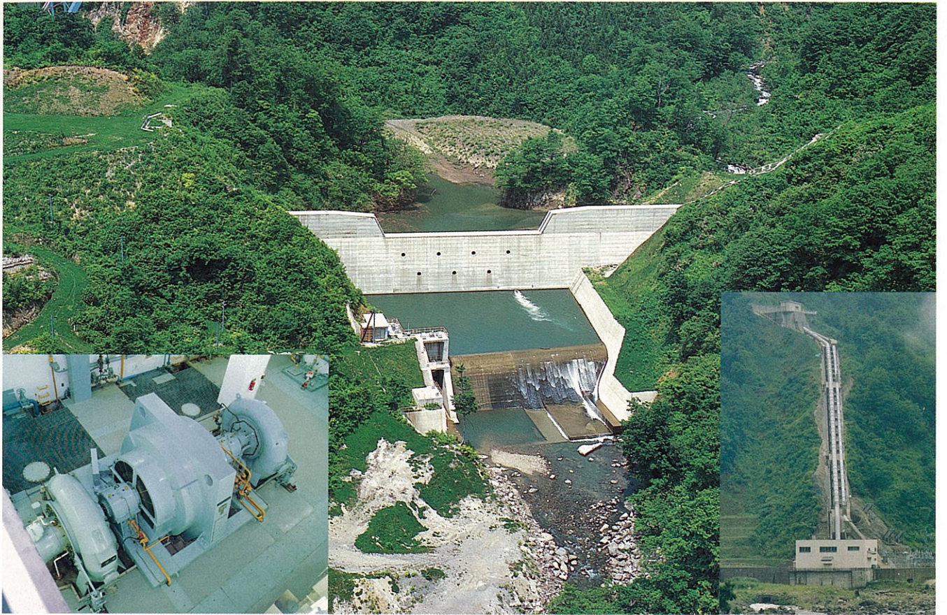
大越川(西川町)に完成した大越第4ダム。副ダムより取水し発電に利用している
