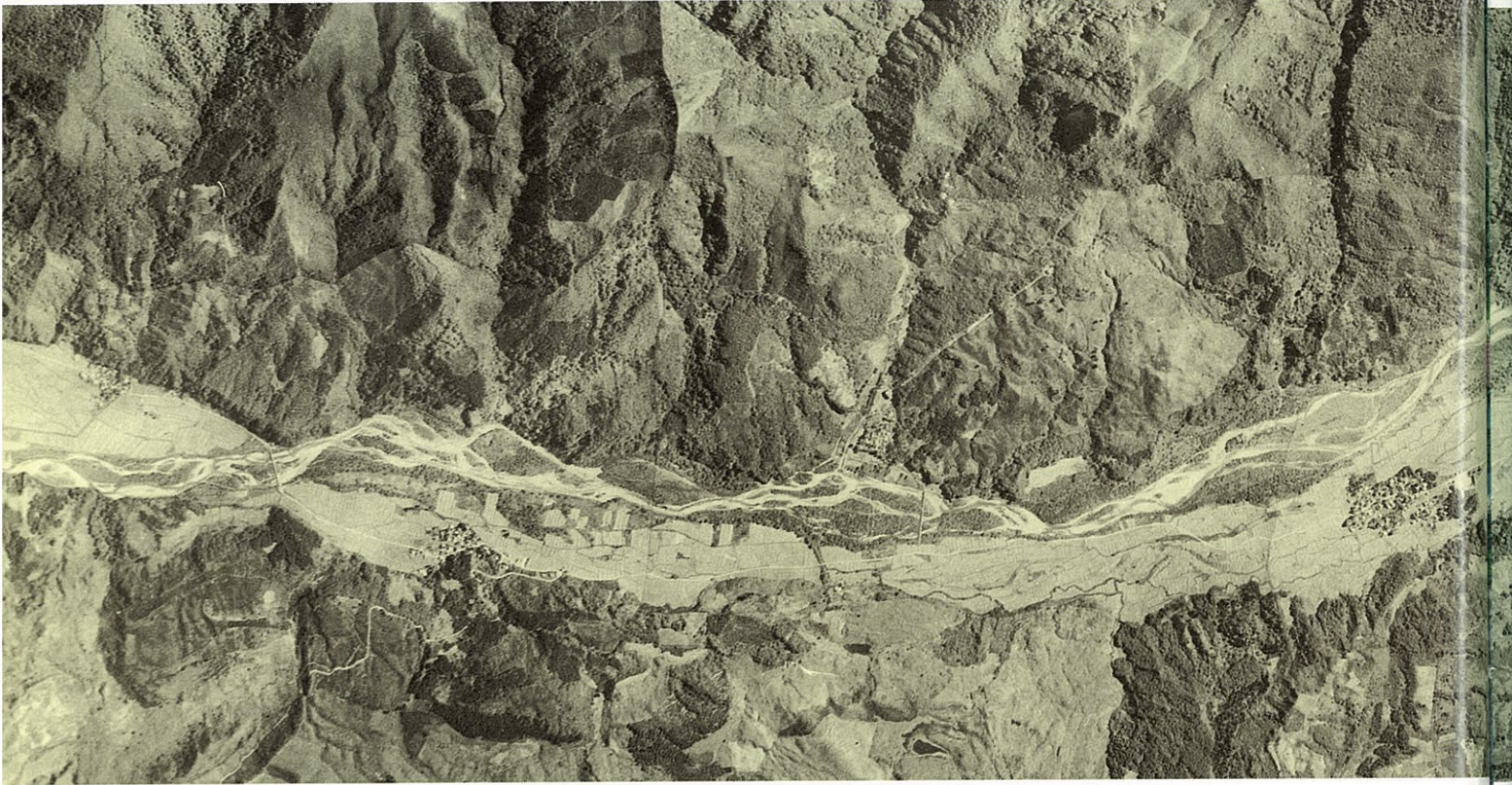
立谷沢川流路工着工前（昭和41年9月）
