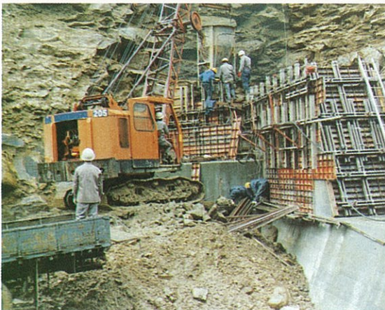
中沢ダム工事中
