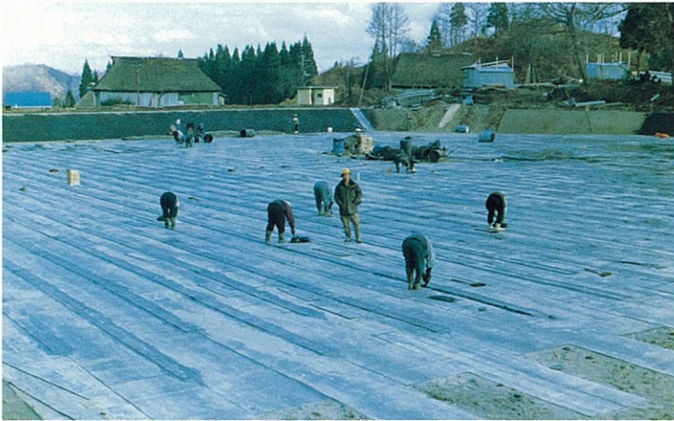
五郎八沼の浸透防止工事中
