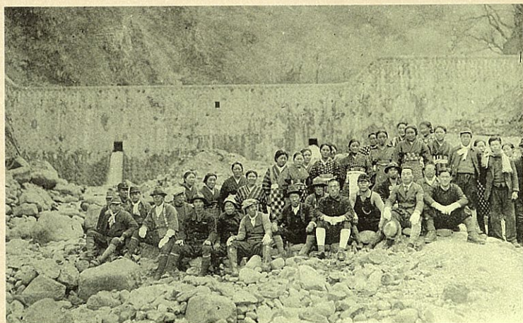
濁沢第2ダム完成の写真(写真提供/渡辺多松氏)
