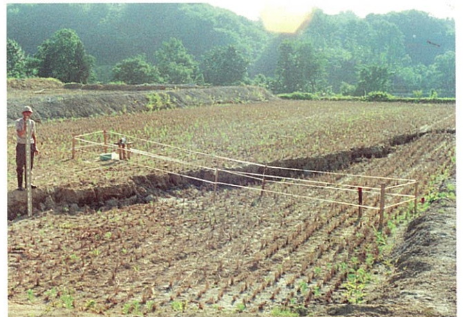
▲ 昭和45年春、発生地すべり（中央地区）
