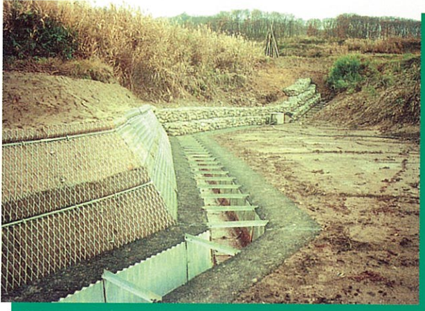
◀ コルゲートフレียมによる水路工
