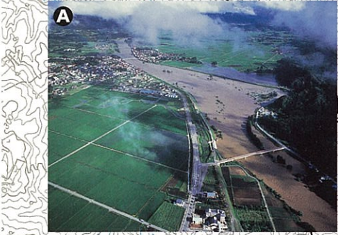
黒滝橋下流上空 (大石田町)
