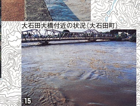
大石田大橋付近の状況 (大石田町)
