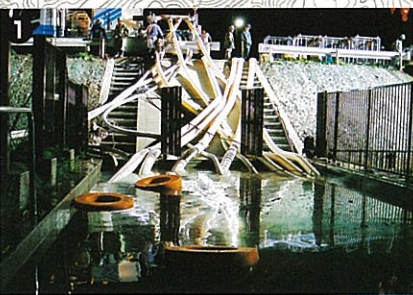
蔵岡地内の夜間の内水排除状況(戸沢村)
