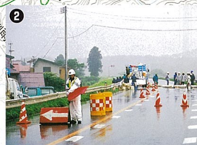
蔵岡地内の国道47号の通行止め状況(戸沢)
