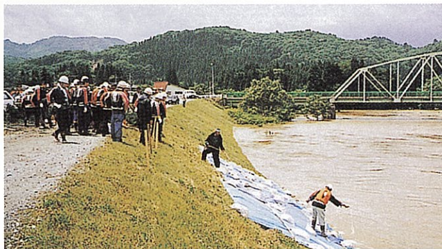
平成9年6月29日 堤防を守る水防団（大石田町豊田地区）
