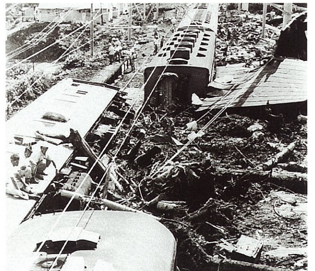
最上川支川真室川 昭和50年8月6日 真室川町 大滝地区 臨時停車の列車を土石流が襲う
