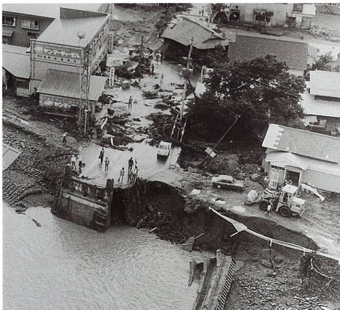
最上川右支川鮭川 昭和50年8月6日 最上郡真室川町 堤防決壊、橋梁流失、路上にある流失家屋
