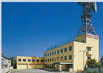
新庄工事事務所
