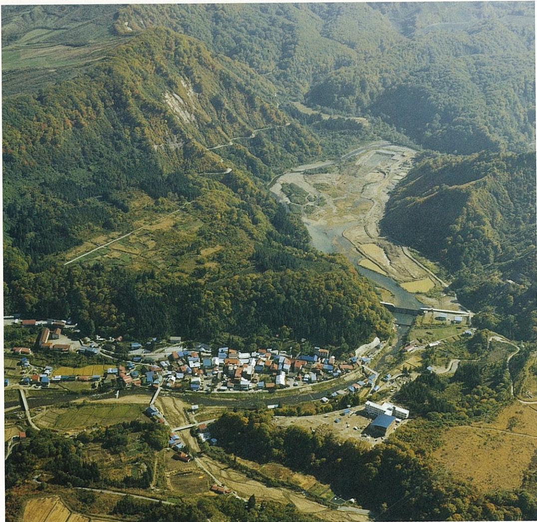
肘折温泉街を土砂災害から守る肘折ダム
