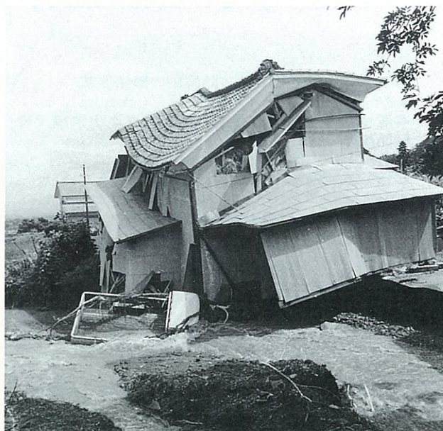
越中山地区越中沢川（昭和46年7月16日）
