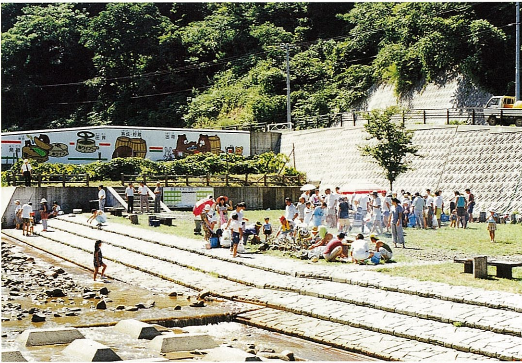
地域活性化をめざした砂防事業（戸沢川ダム）
