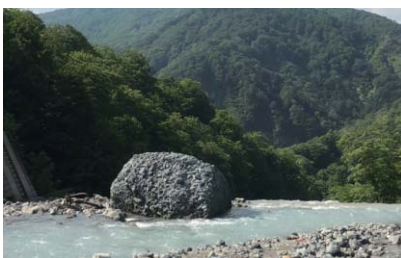
濁沢第五砂防堰堤の上でとまった巨石（平成23年の深層崩壊）（写真提供：山形大学・八木浩司教授）
