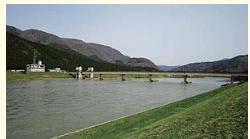
最上川さみだれ大堰
