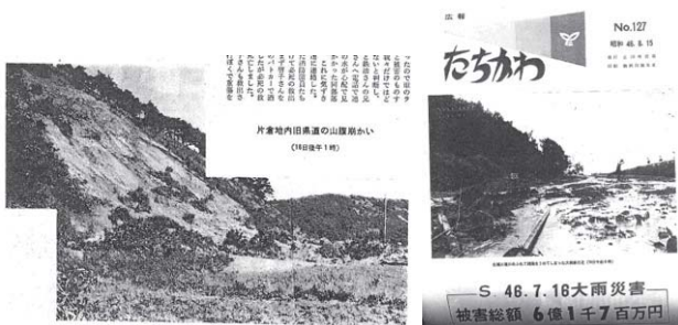
昭和46年(1971)年7月 立川町片倉地内の災害
