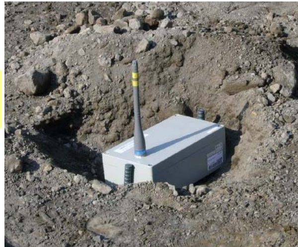
無線運用型振動検知式土石流センサー (土木研究所らで開発)
