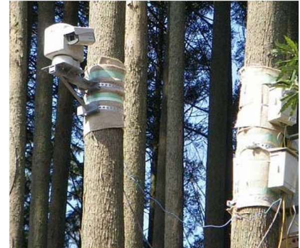
霧島山の緊急対応で設置された可搬型監視カメラ
