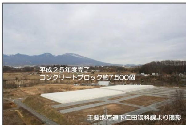
参考-浅間山におけるコンクリートブロックの備蓄事例 (国土交通省利根川水系砂防事務所 “浅間山砂防だより第5号H25.12.20より”)
