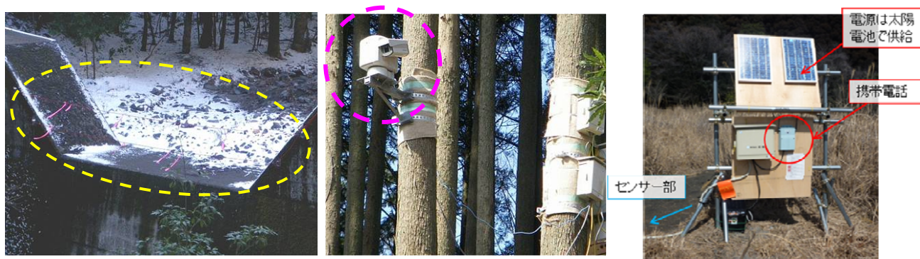
図 4-11 霧島山（新燃岳）の緊急対応で設置された土砂移動検知センサー
