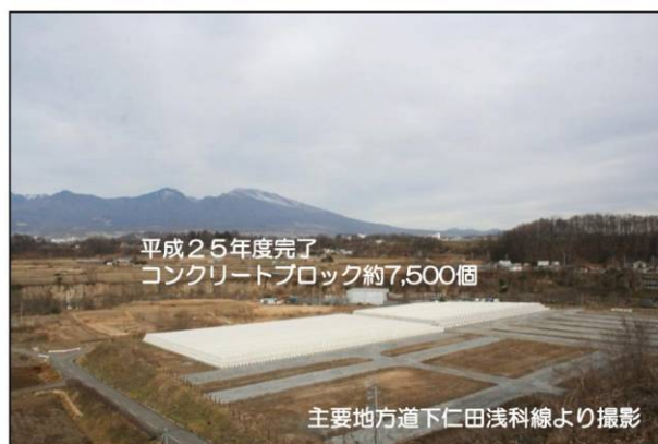
参考-浅間山におけるコンクリートブロックの備蓄事例 (国土交通省利根川水系砂防事務所 “浅間山砂防だより第5号H25.12.20より”)
