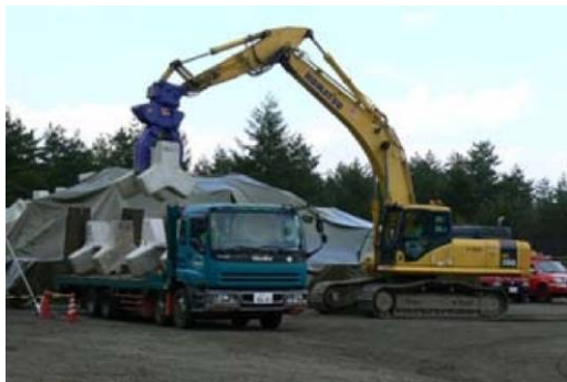
国土交通省による緊急減災対策工施工訓練
