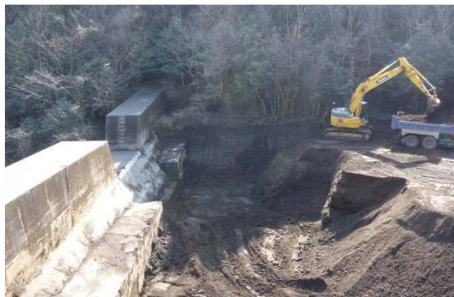
既設砂防堰堤の除石
