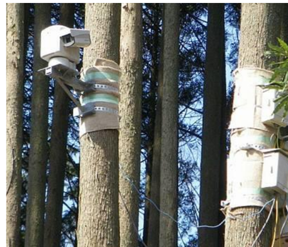
霧島山の緊急対応で設置された可搬型監視カメラ
