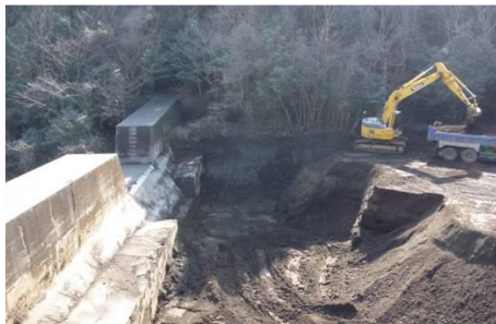
既設砂防堰堤の除石
