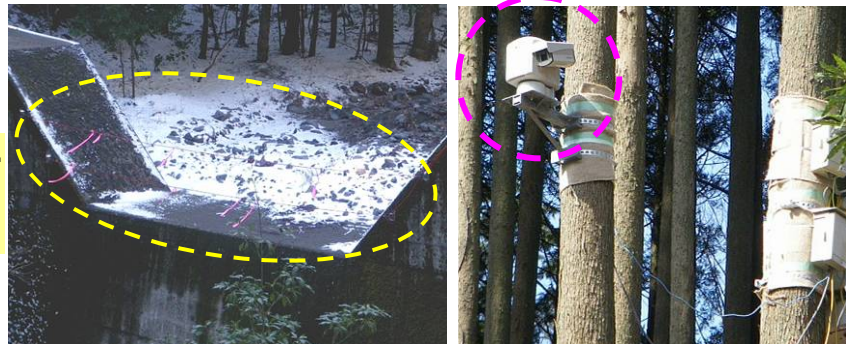
霧島山(新燃岳)の緊急対応で設置されたワイヤーセンサーと可搬型監視カメラ
