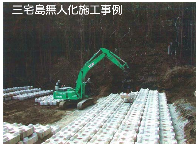
仮設堤工（ブロック積工）
