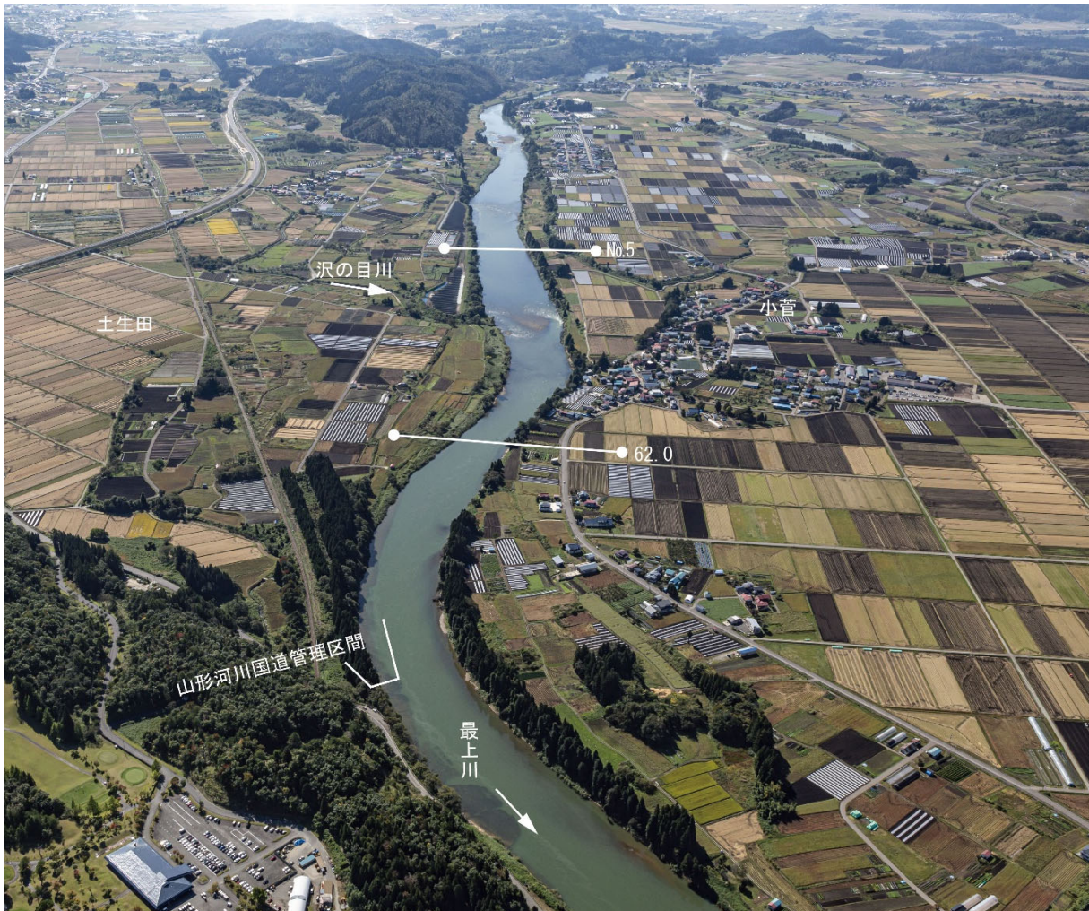
令和2年7月豪雨による洪水
