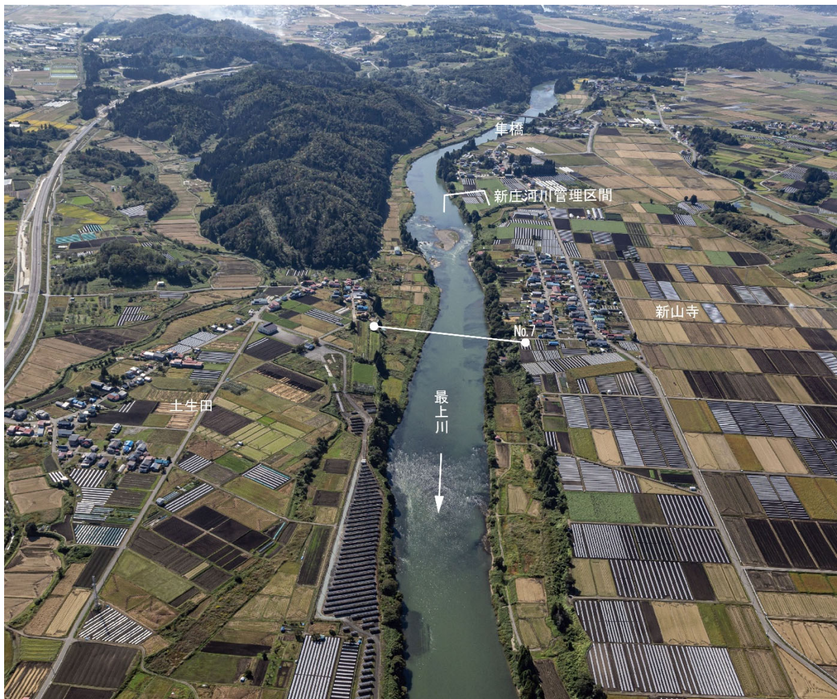
令和2年7月豪雨による洪水
