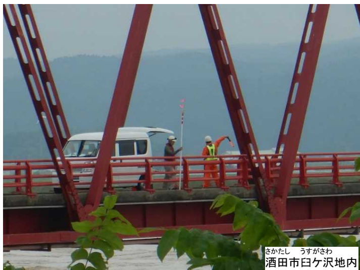
うすがさわ 臼ヶ沢水位・流量観測所地点(調査:(株)出羽測量設計)
