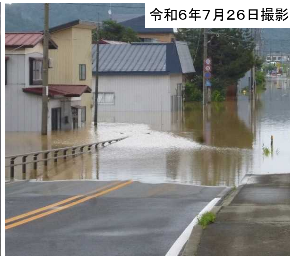
戸沢村古口地区の浸水状況
