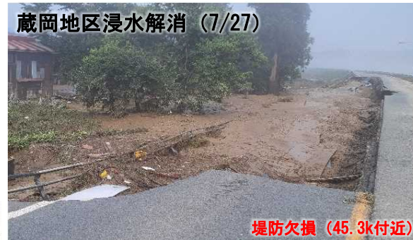
堤防欠損 (45.3k付近)
