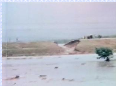
中川原地区破堤状況
