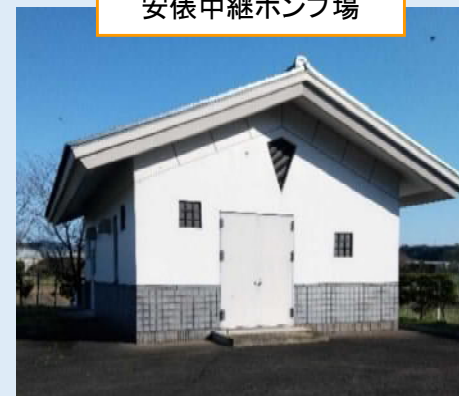
安俵中継ポンプ場
