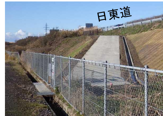
③避難路(スロープ) R3.12月完成
