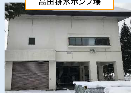
高田排水ポンプ場
