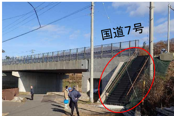
①避難路(階段) R3.3月完成
