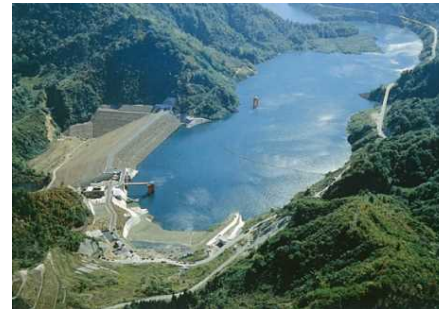
白川ダム／飯豊町 (着工昭和46年／完成昭和50年)
