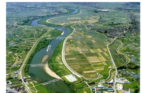
大久保遊水地／村山市・河北町 (着工昭和50年／完成平成9年)
