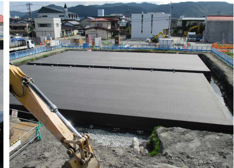
貯水槽の完成
