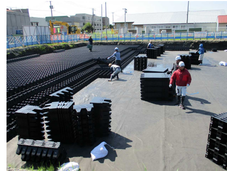
貯留材の設置状況
