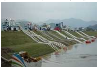
排水ポンプ車による緊急排水
