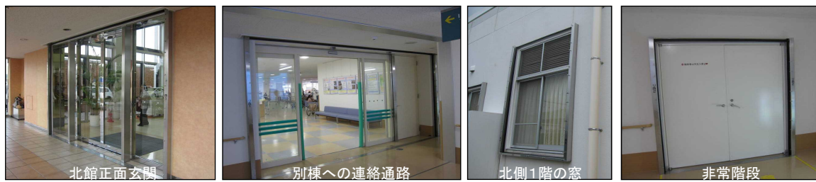
止水板のための角落との設置
