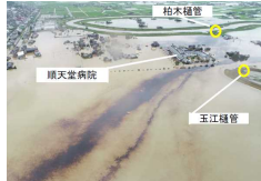
⑧六角川周辺における浸水被害状況 (佐賀県大町町)
