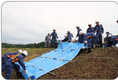
シート張り工の訓練実施事例(真室川町の事例)
