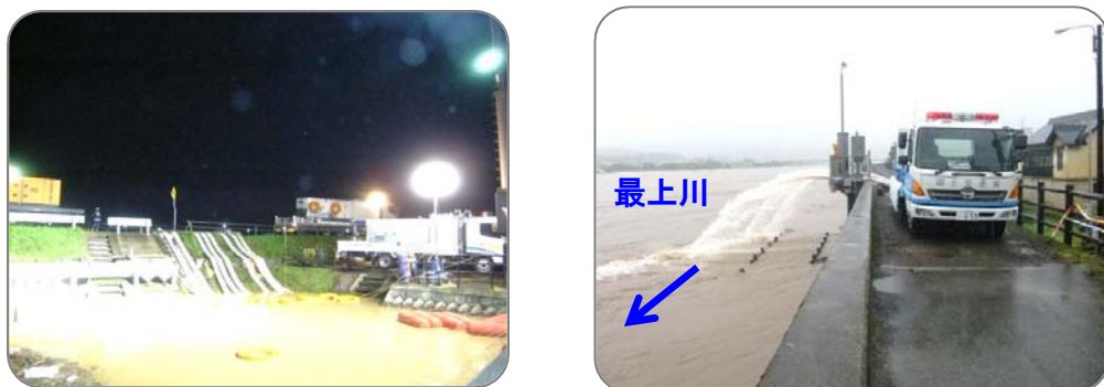
排水ポンプ車による緊急排水の事例(左:戸沢村蔵岡地区、右:大石田町横山地区 H25.7)
