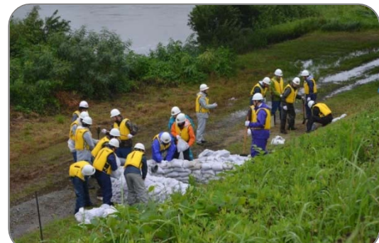
月の輪工の訓練実施事例(大蔵村の事例)
