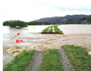
鮭川の増水による堤防決壊状況 (鮭川村観音寺地区)
