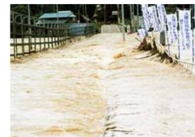
最上川の増水による道路冠水状況 (大蔵村白須賀地区)
